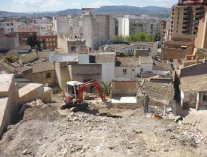
Fig. 21: Excavaciones en la muralla de la calle Subida de Santa Bárbara.
