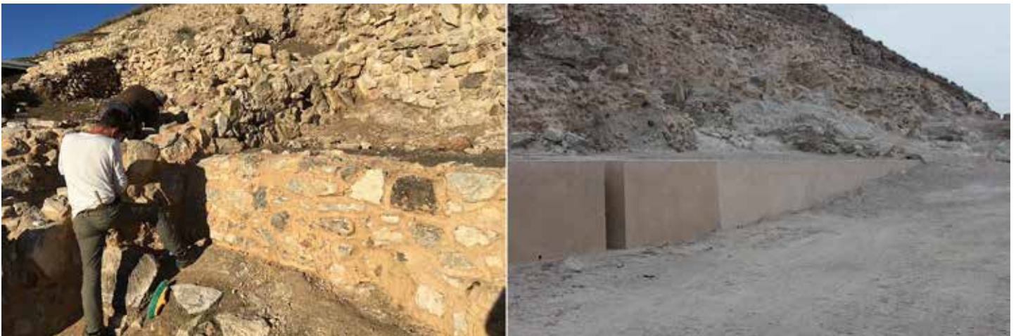
Fig. 8: Diferentes trabajos de consolidación en el yacimiento.
