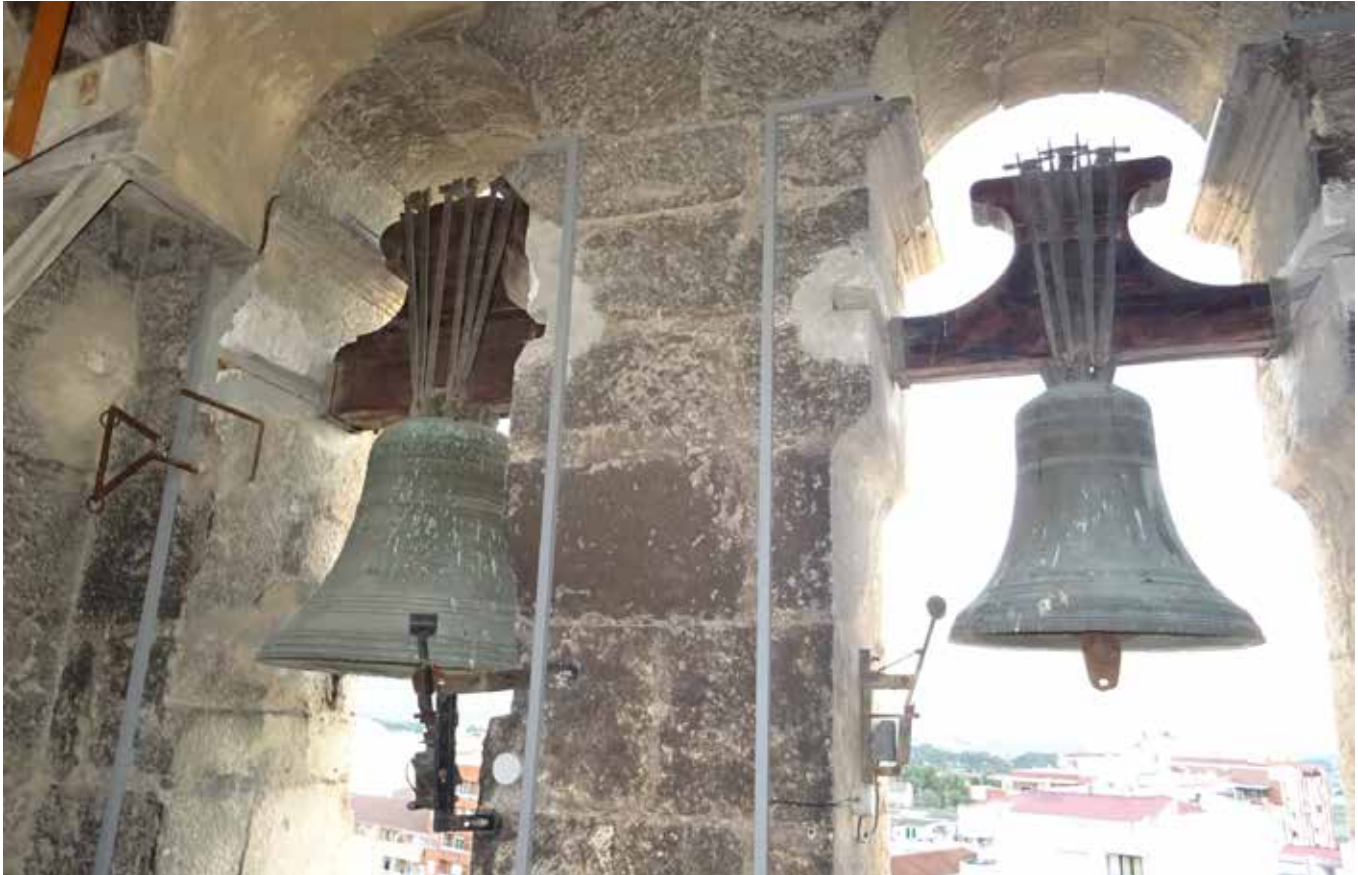
Fig. 3: Las campanas de Santa María mal mecanizadas, sin cuerdas para el toque manual. (25-10-2018).
