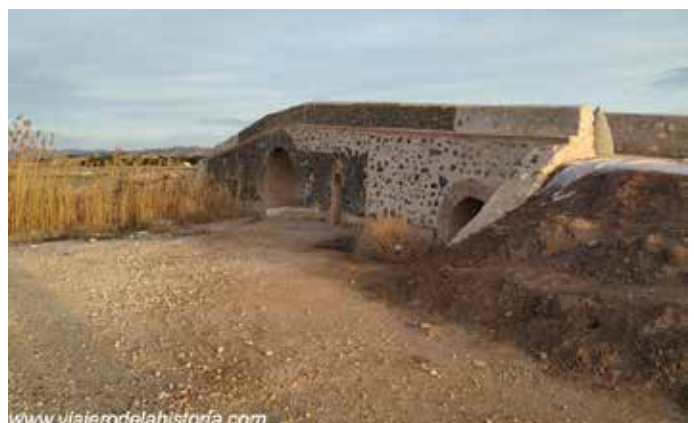
Fig. 20: Restauración del Puente del Salero.
