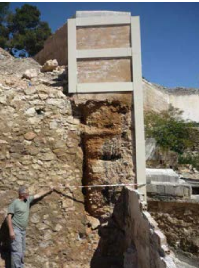
Fig. 22: La muralla de la calle Subida de Santa Bárbara.
