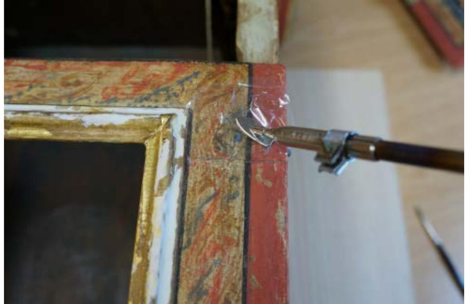
Fig. 11. Consolidación y detalle de la capa de oro que se conserva.
