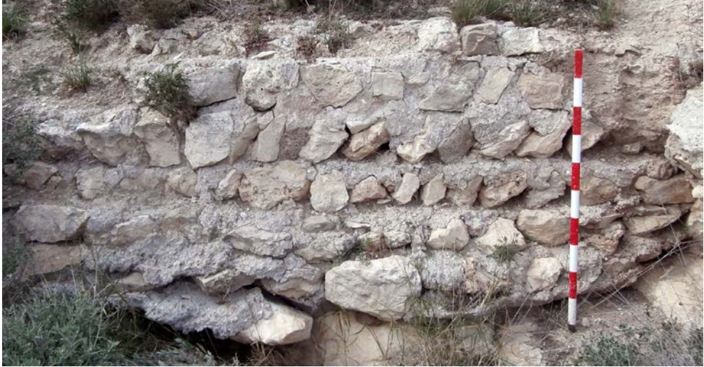
Ejemplo de lienzo de mampostería (UM 121) situado en la zona superior del castillo.
