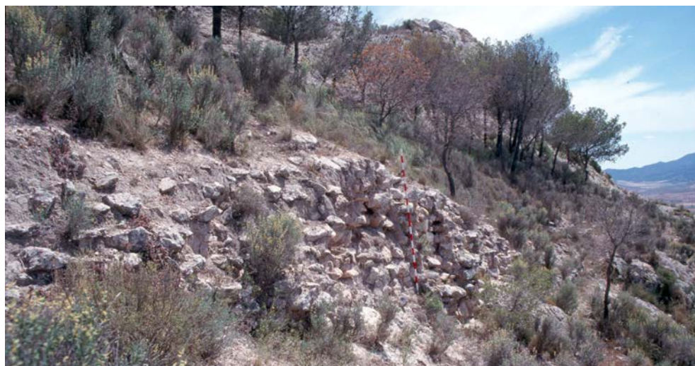
Muralla del recinto inferior a la que le falta la cara externa.
