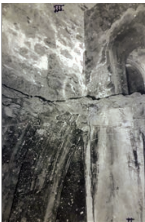
Fig. 19. Forjado de la tercera planta volado en 1813 (Foto: Diputación de Alicante)
