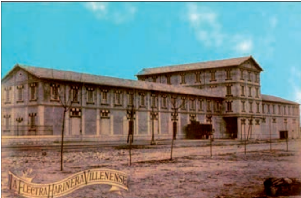
Fig. 64. Vista de la fachada occidental. Año 1909
