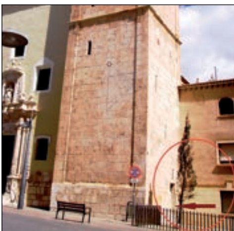
Fig. 71. Iglesia, torre y casa parroquial de Santa María. Se aprecia el reloj de sol en la fachada de la torre y el acceso lateral marcado con la flecha
