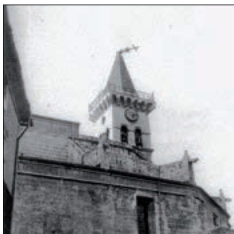
Fig. 127. Remate del chapitel doblado por la tormenta
