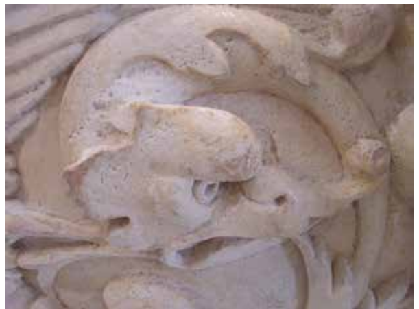
Limpieza de costra negra
