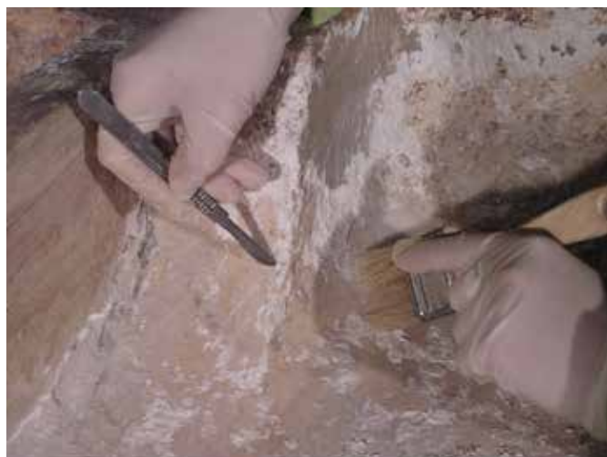
Eliminación capa de cemento y yeso
