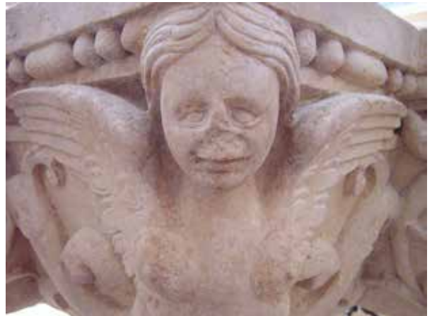
Limpieza de costra negra
