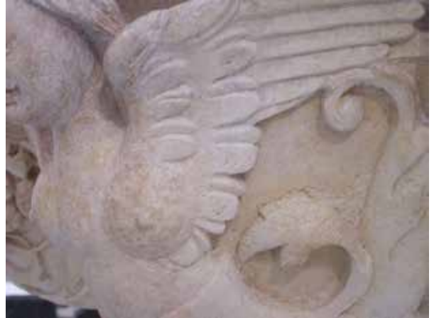
Limpieza de eflorescencias salinas
