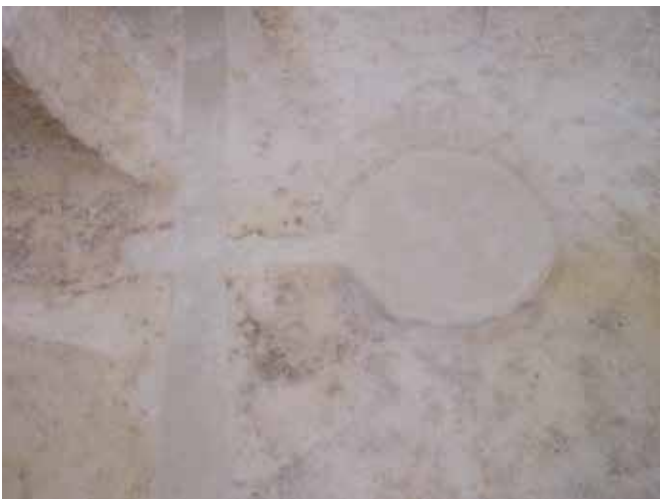
Desague después de la restauración
