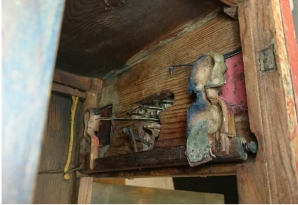
Fig. 9. Detalle del interior del reloj. Estado de conservación del mirón.
