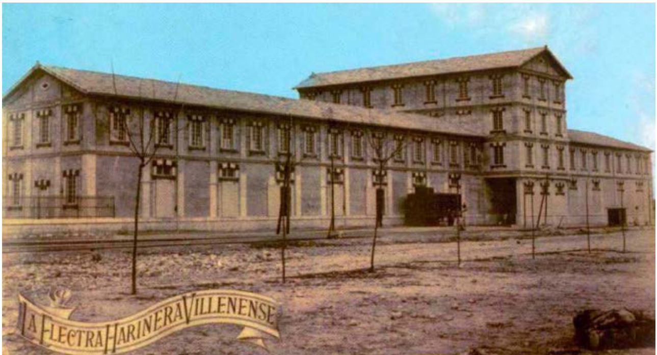
Fig. 1. La Electra-Harinera Villenense tras su inauguración. Se observa el avance del cuerpo central, para permitir el acceso de los trenes a la fábrica.
