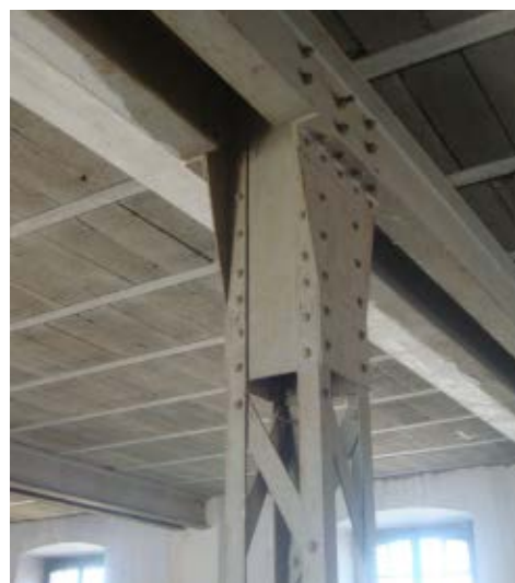
Fig. 4. Adornos de cerámica y estructura original roblonada que se van a rehabilitar.
