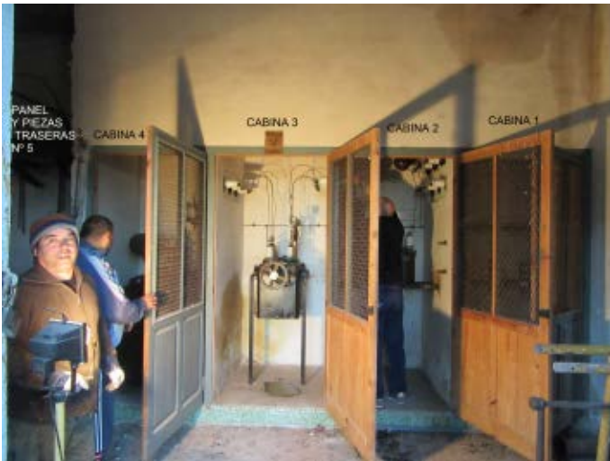
Fig. 30. Vista interior del motor.
