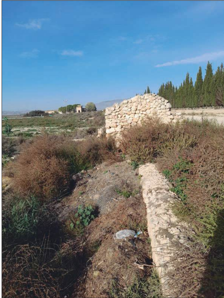
Figura 8: La Mota. Estructura hidráulica junto al camino viejo de Caudete-Villena.
