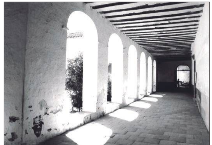
Figura 15: El corredor norte de la planta baja, antes del derribo. La persona del fondo se encuentra en el paso al patio trasero. Foto: MUVI. Museo de Villena.
