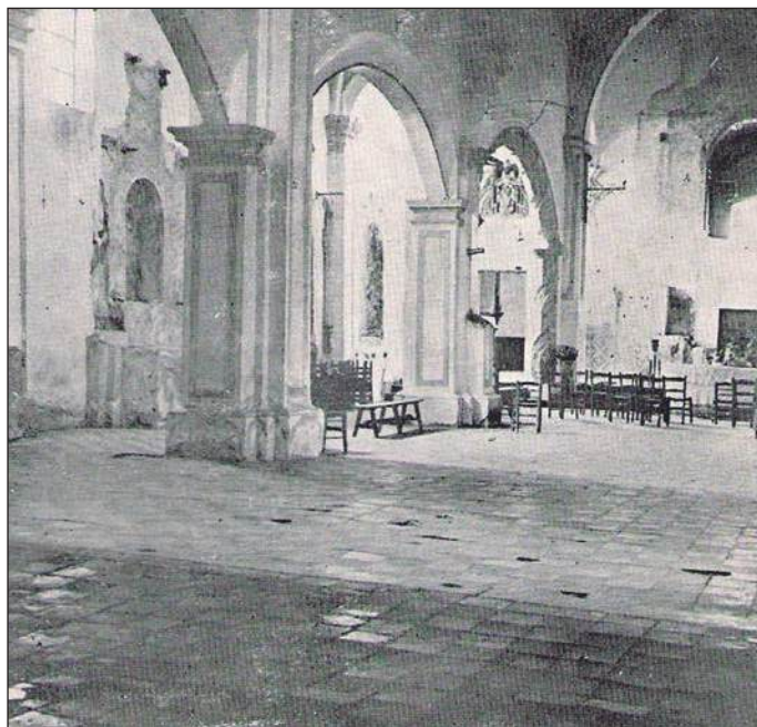
Figura 4: Interior de la iglesia después del 24 de julio de 1936, donde se aprecian los retablos destruidos. Foto: www.villenacontame.com
