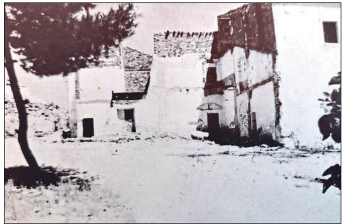
Fig. 8.4: La zona anterior, después del derribo.
