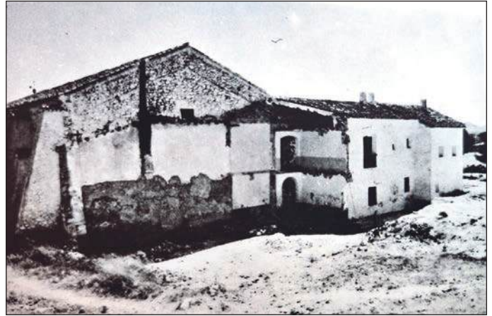
Fig. 8.2: La zona anterior, después del derribo.
