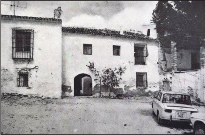
Fig. 8.1: Parte ruinoso recayente al Parador antes del derribo.
